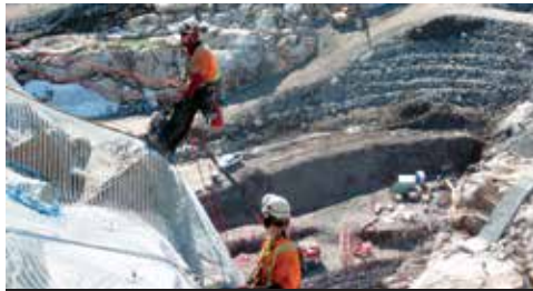
Installation de grillage plaqué
