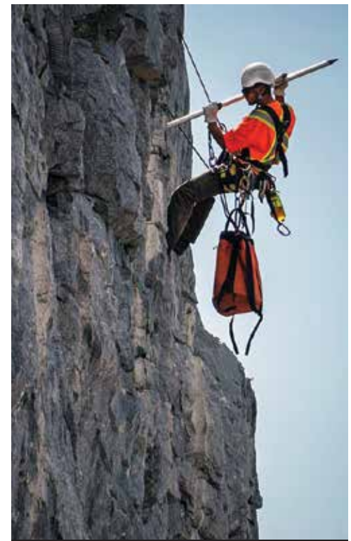
Écaillage pour sécuriser l'accès à la base des parois
